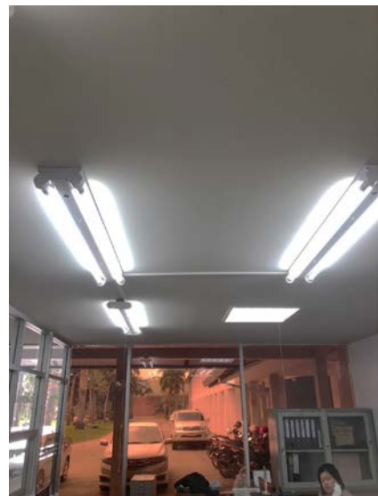
ดำเนินการเพิ่มระบบไฟส่องสว่างชนิดราง 1 จุด 2 หลอด
