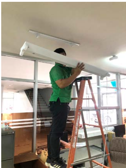
ดำเนินการเพิ่มระบบไฟส่องสว่างชนิดราง 1 จุด 2 หลอด
