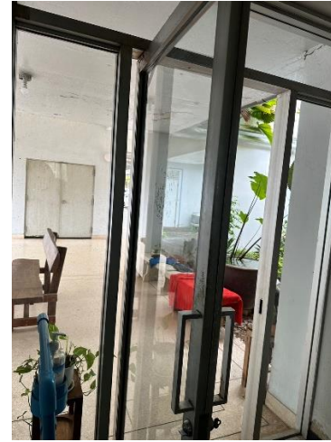
ควรมีการซ่อมประตูทางเข้าฝ่ายส่งเสริมฯ เนื่องจากใช้คประตูลำรุด (ประตูไม่สวิง)
