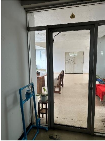
ควรมีการซ่อมประตูทางเข้าฝ่ายส่งเสริมฯ เนื่องจากใช้คประตูลำรุด (ประตูไม่สวิง)
